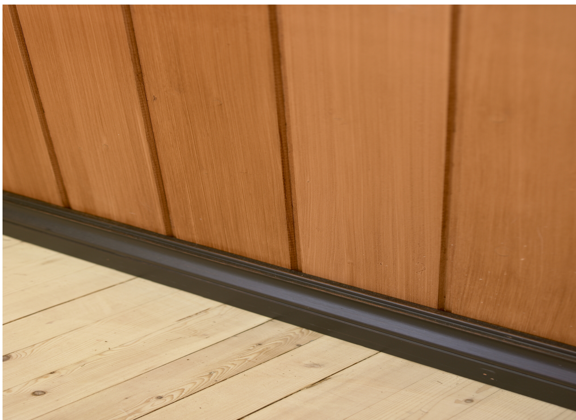
Spennende møte mellom lasert vegg, mørkmalt fotlist og nyslipt gulv tilsatt hvitpigmentert gulvsåpe.
