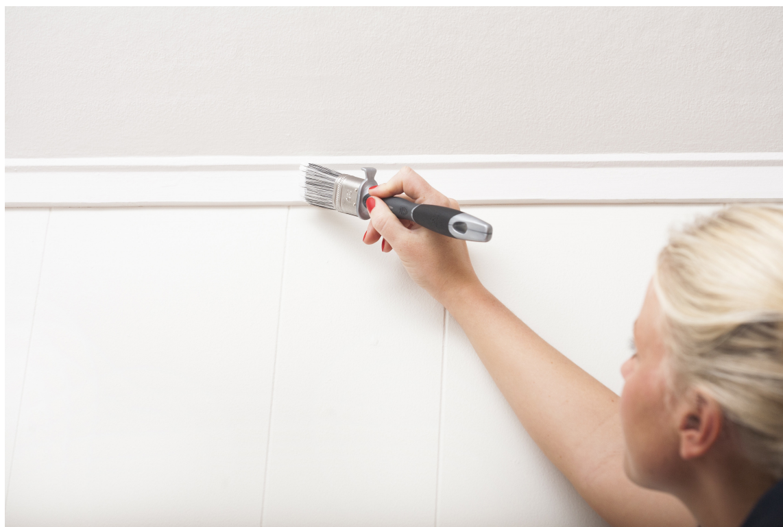
LISTER: Tak- og gulvlister gjør rommet komplett. Men de må også behandles enten med vask eller grunning før de kan males. Det finnes egen maling for lister. (Foto: Jordan)
