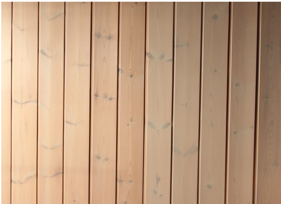
Her er den gulnede veggen påført først ett strøk (til venstre) og deretter to strøk (til høyre) Panelbeis.
