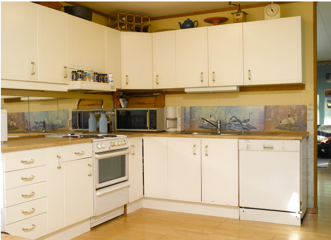
Det gamle kjøkkenet var slitt, og det var ønskelig med mer luft. Veggene mot stuen ble derfor revet, og ny innredning kom inn.
