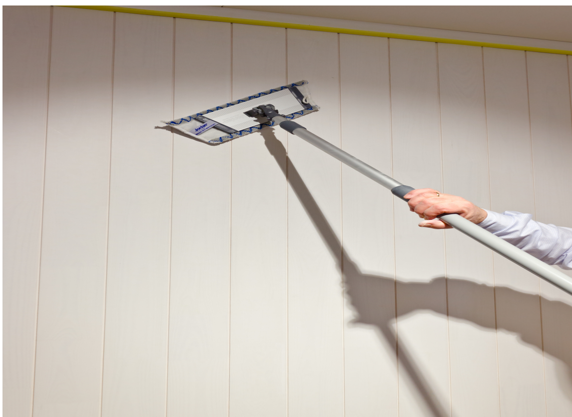
Med godt forarbeid sikres flott finish. Start alltid med å vaske og støvtørke flaten som skal males.
