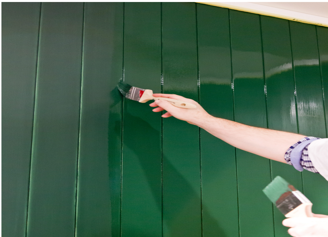
Bruk en skrå pensel i hjørner og til å påføre maling i panelets profiler.
