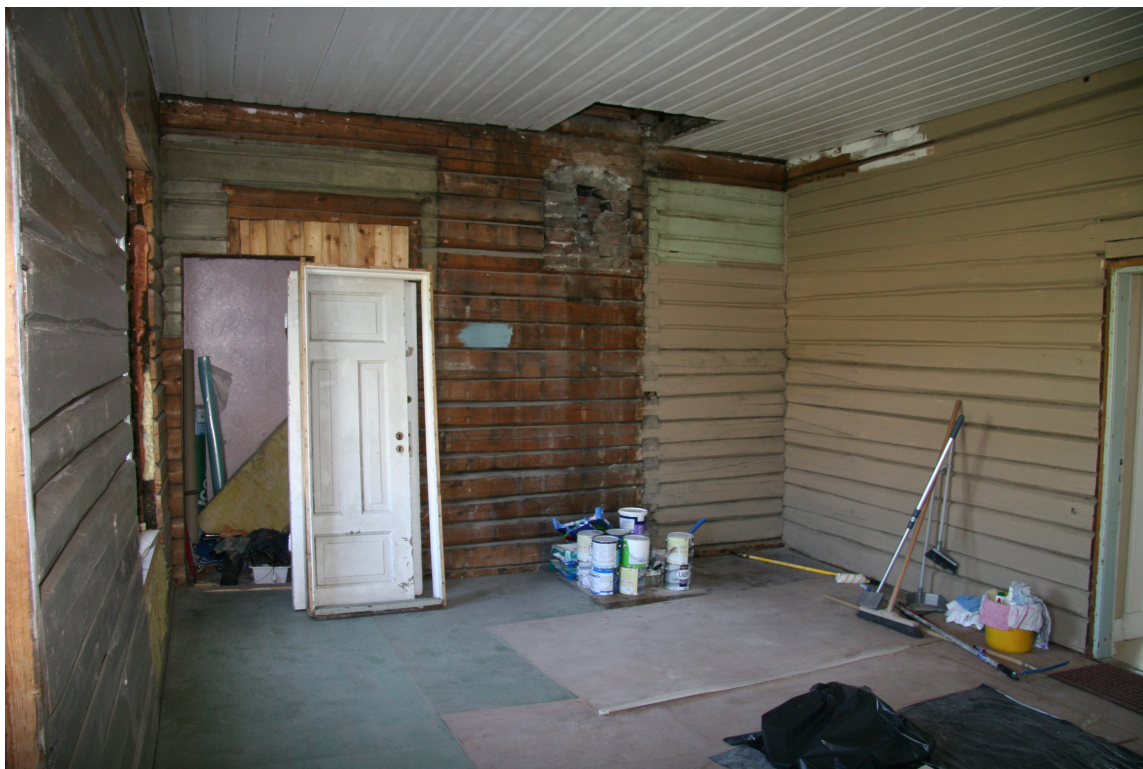
Venterommet, mange arbeidstimer før det ble kjøkken.
