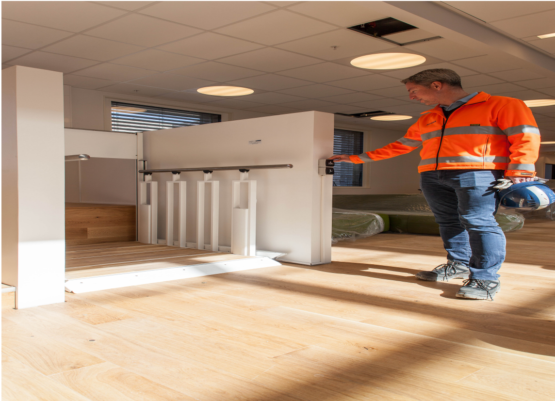
Prosjektleder Peter Hesselroth fra Skanska demonstrerer trappen som forvandles til heis, for at rullestolbrukere skal kunne få tilgang til takterrassen.
