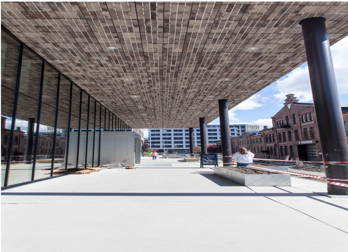
Det overbygde inngangspartiet har fått tak av spesialbrent teglstein.
