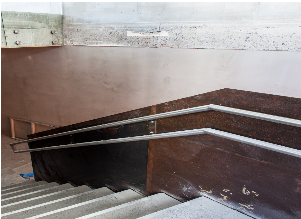
Leietaker til denne kjelleretasjen har bestilt så tøffe overflater som mulig, og har til og med dekket noen av veggene med Beton Cire for virkelig å understreke rå betong.
