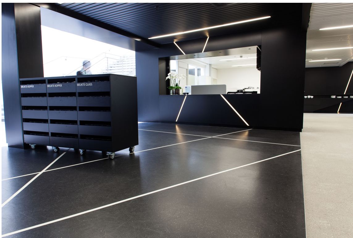
Fellessone har gulv med spesialdesignet mønster, tilskåret på stedet.
