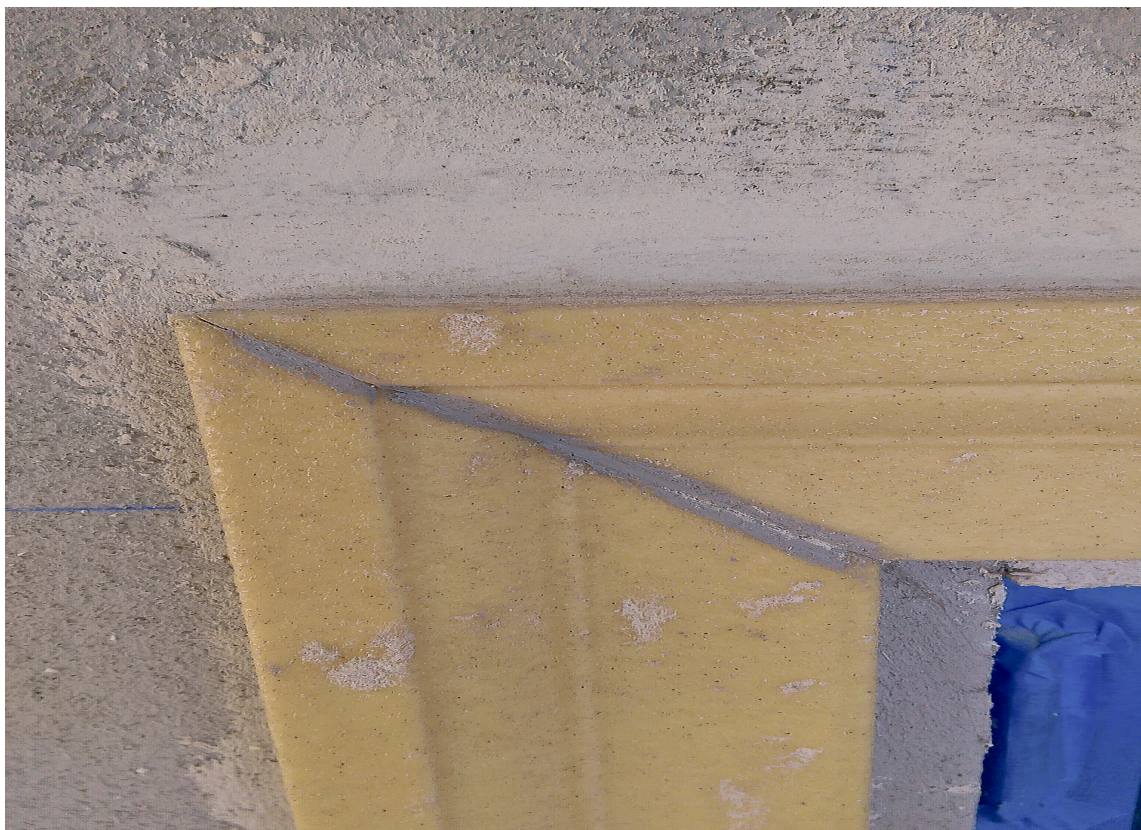
Gjæringer og skjøter fuges med filler som blåses med sand slik at de oppnår samme struktur som pussen.
