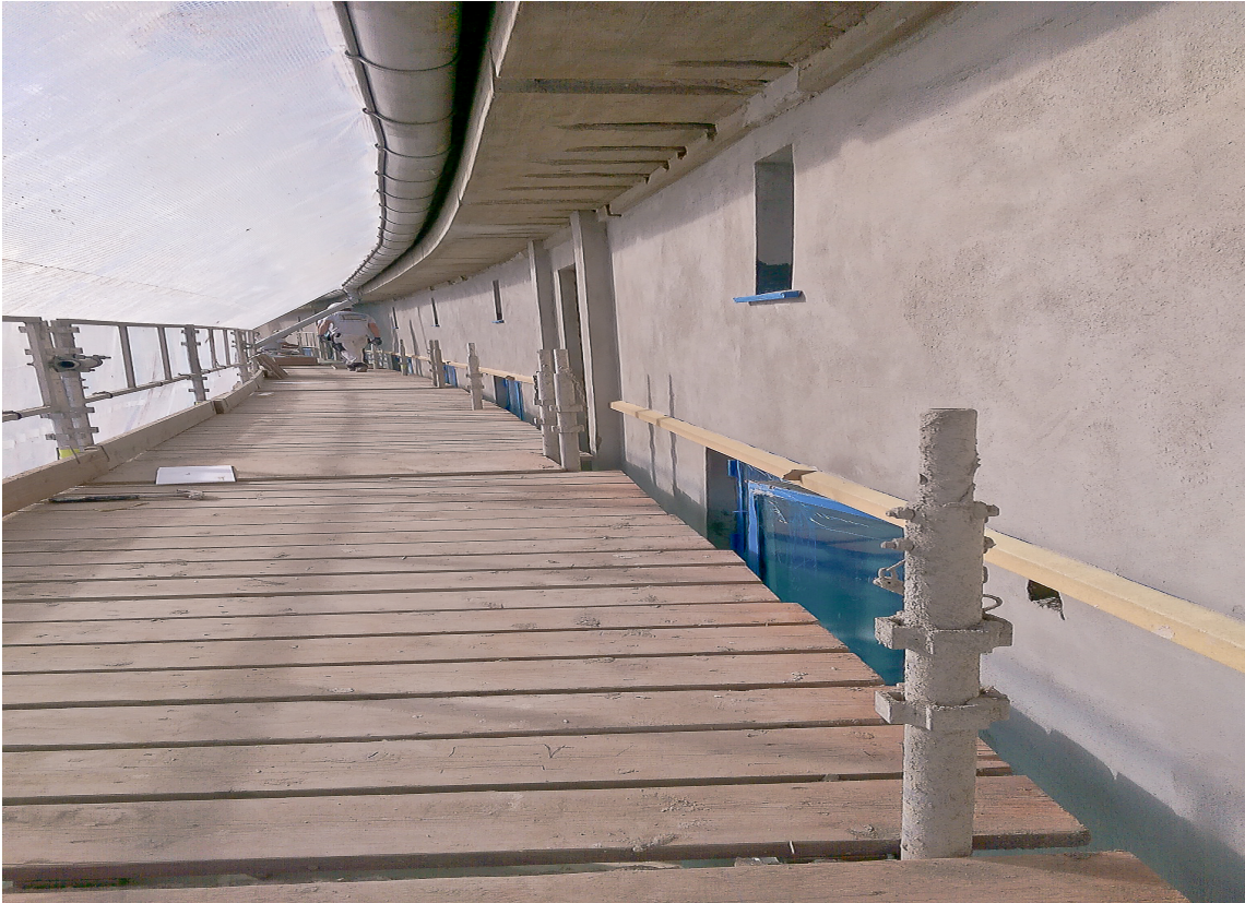
Materialet er såpass fleksibelt at fasadens bue tas opp av listene.
