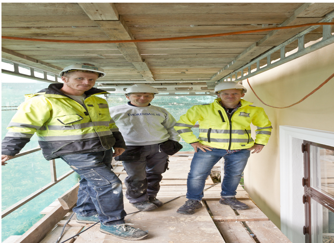
Jean Paul Beresford, Thomas Volkmer og Ingvar Røang er fornøyde med nesten ferdigstilt fasade på det bevaringsverdige bygget mot Lammers gate.
