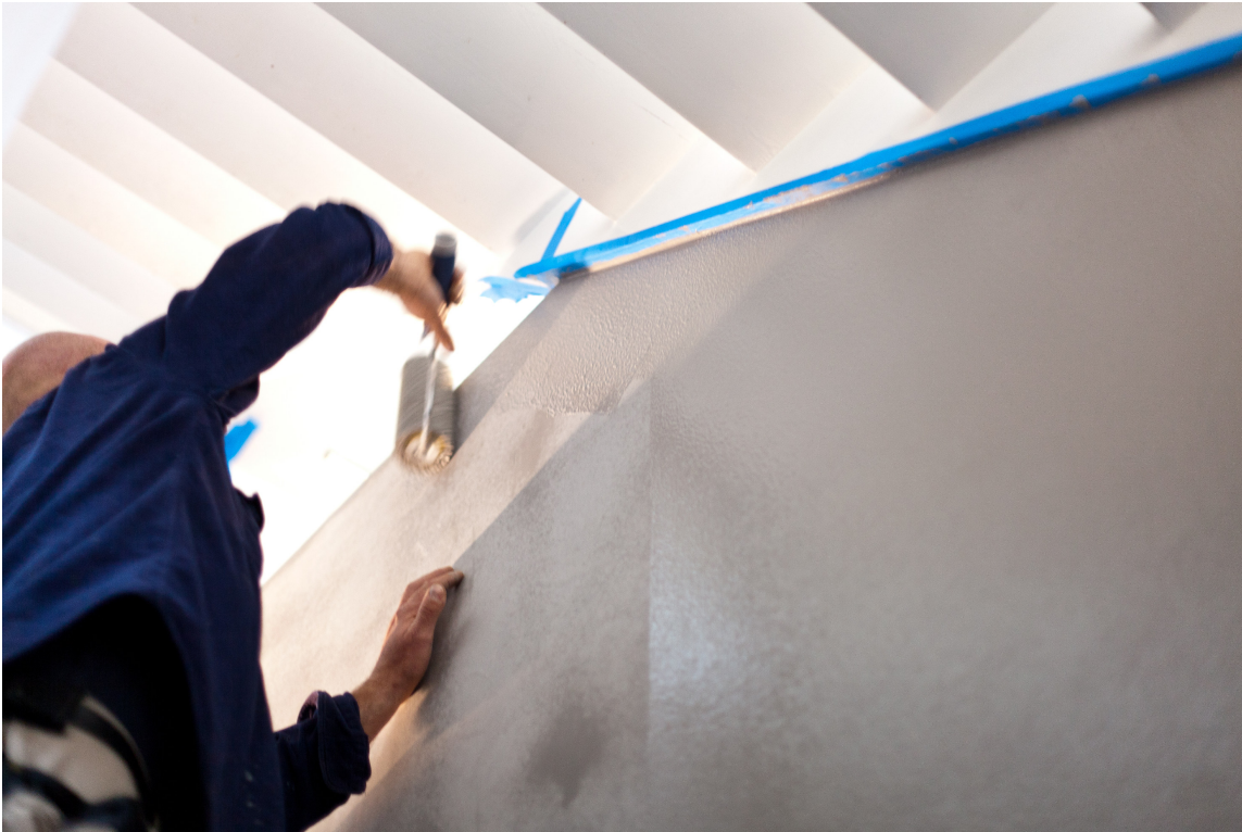
Béton Ciré lager millimetertynne sjikt. Sparkelen påføres med strukturrull og sparkelbrett eller kun med sparkelbrett
