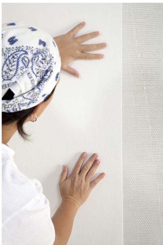
Her er det benyttet Veggfornyer for å bli kvitt strukturstruen.
