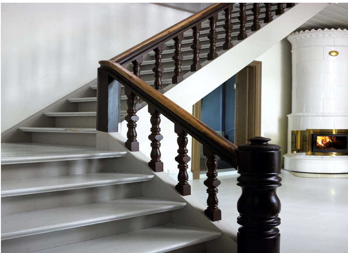
En nydelig utgave av arten... Her er fire farger tatt i bruk: S 1502-Y på inntrinn, S 3005-Y20R på opptrinn og vanger, S 8010-Y70R på sprosser og S 8505-Y80R på stolpen. Håndløperen er naturell.
