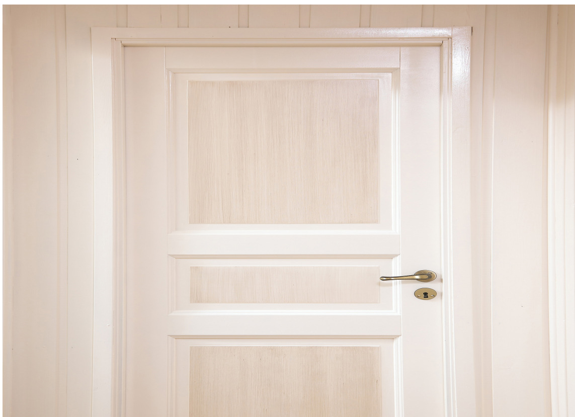
På dette veggpanelet og i taket er det brukt glans 10 (silkematt), på dørbildet og karmen glans 40 (halvblank).
