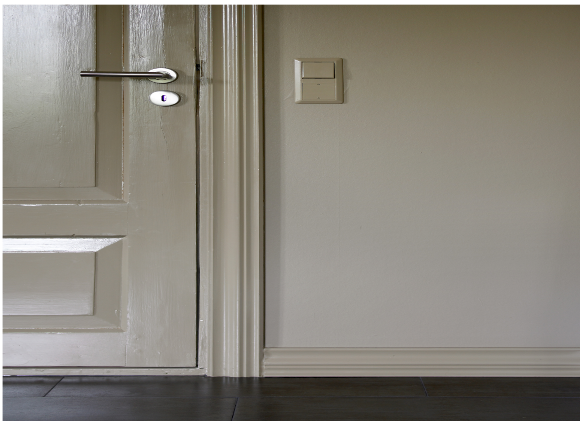
Her er veggen malt med en matt maling, mens treverket er malt med halvblank maling i samme farge.
