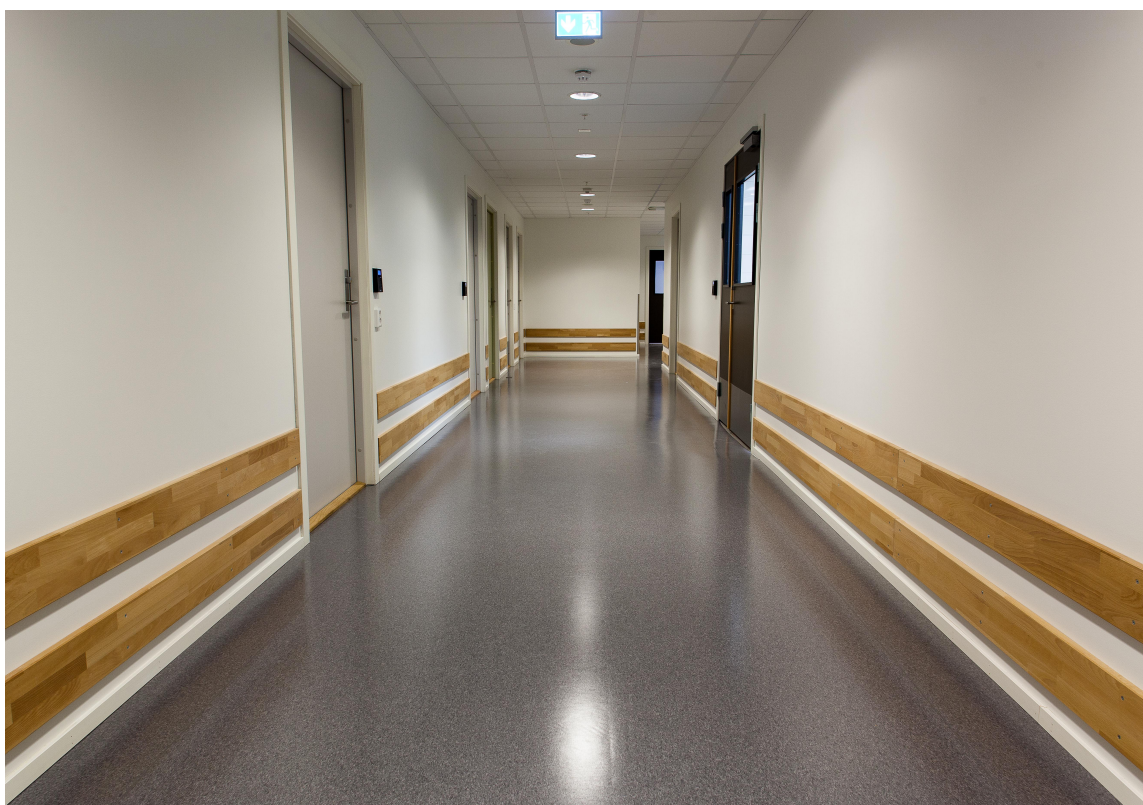
Transport til lagerrom i kjelleren foregår for det meste med traller, og «føre var» har man valgt å kle veggene med beskyttelseskleddning i tre.
