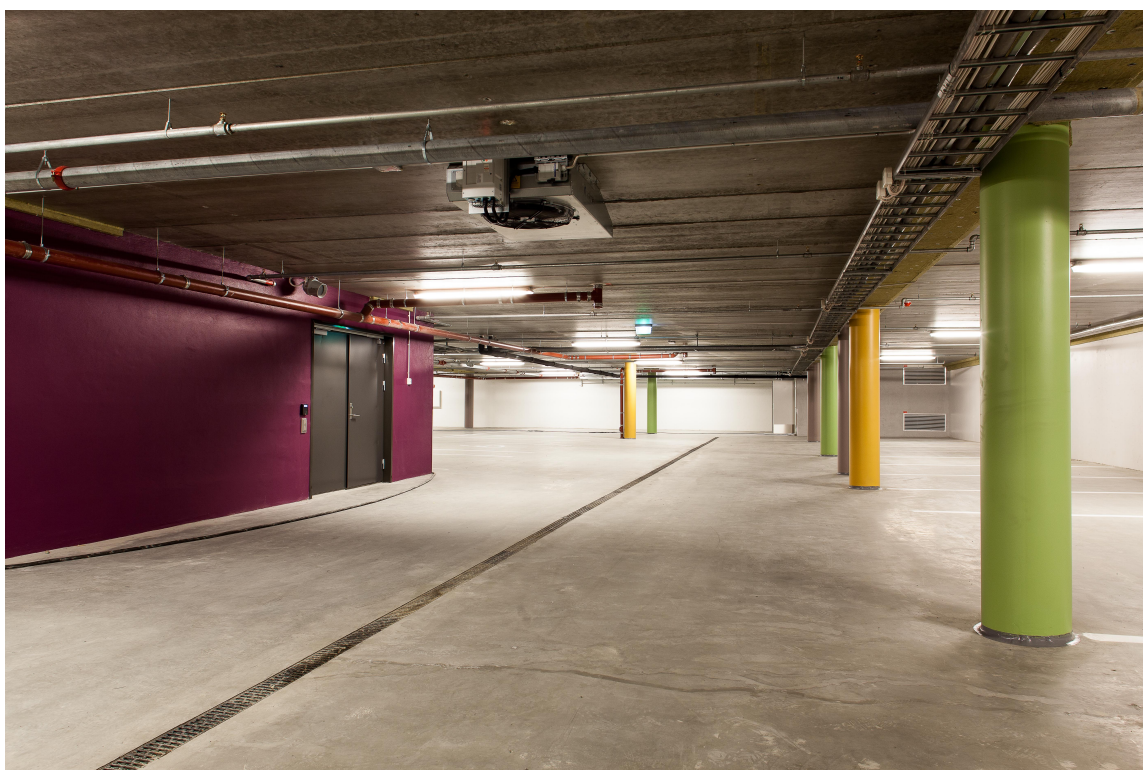
Fargebruken i garasjen skaper trivsel, samtidig som den øker trafikksikkerheten ved at søyler og vegger blir mer synlige.
