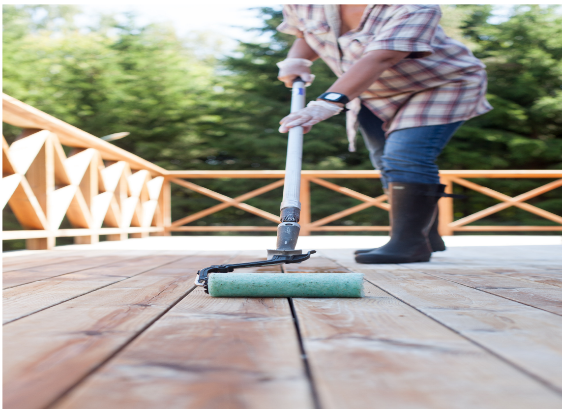
Sioo:X-behandlingen utføres i to trinn, først beskyttelse, så forsegling.
