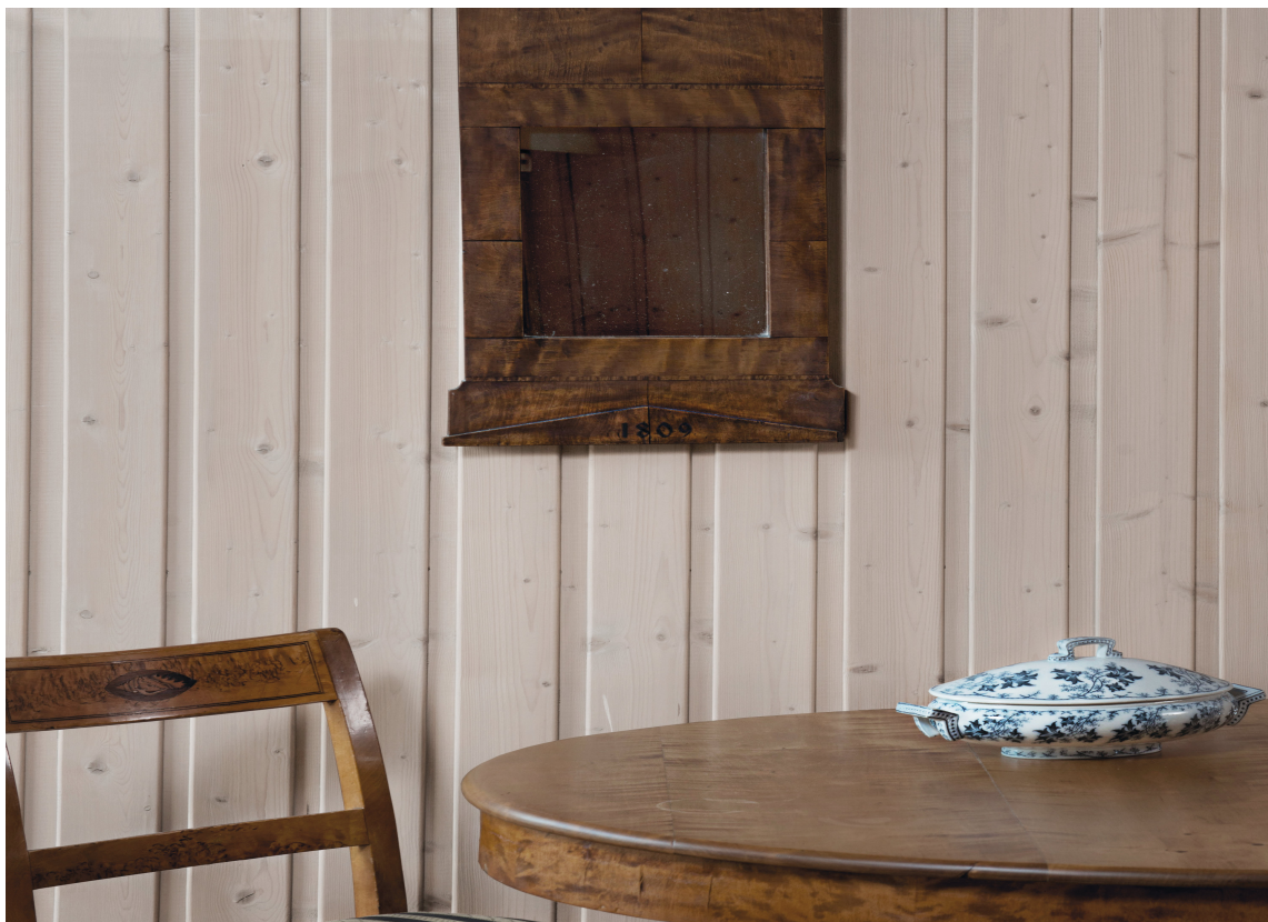
Ett strøk Panellysner var nok for å gi denne veggen et nærmest nytt utseende.
