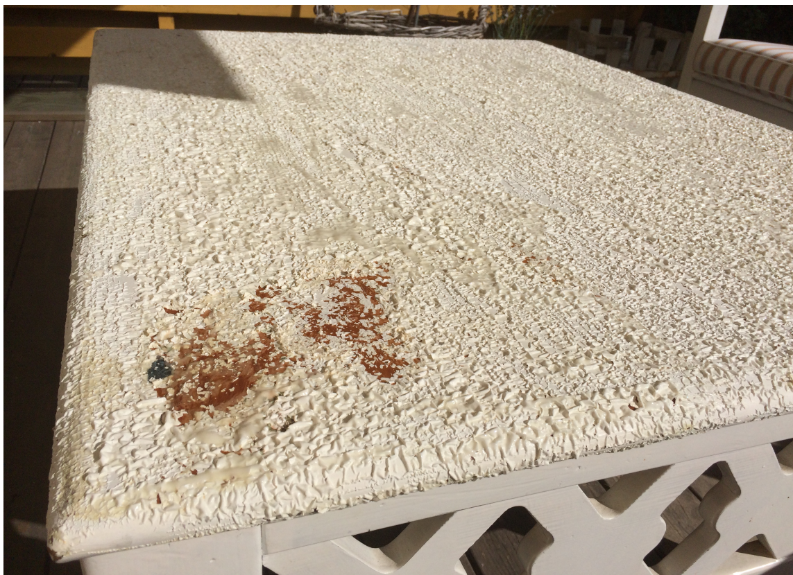
Malingfjernerer er påført, og krakeleringen i gang.
