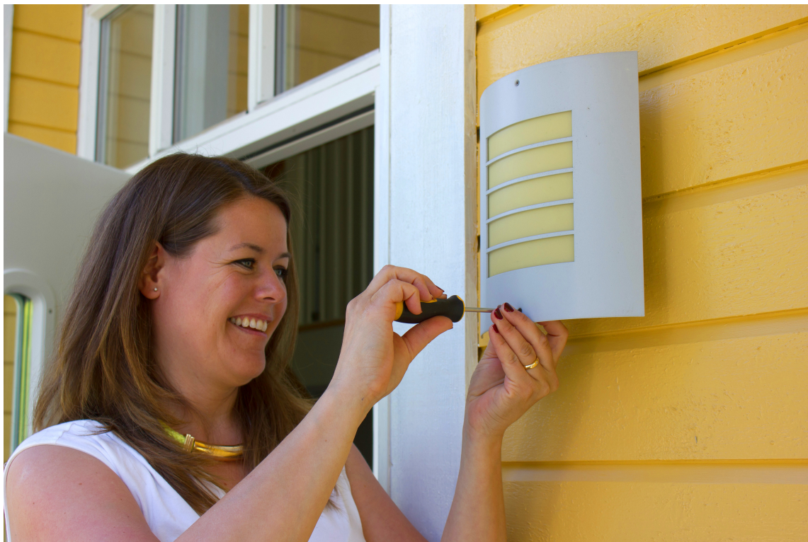
Fornøyd med fargevalget skrur Tale på plass lamper etter endt malejobb. Et lite tips: Skru ned løse deler, ikke mal rundt!
