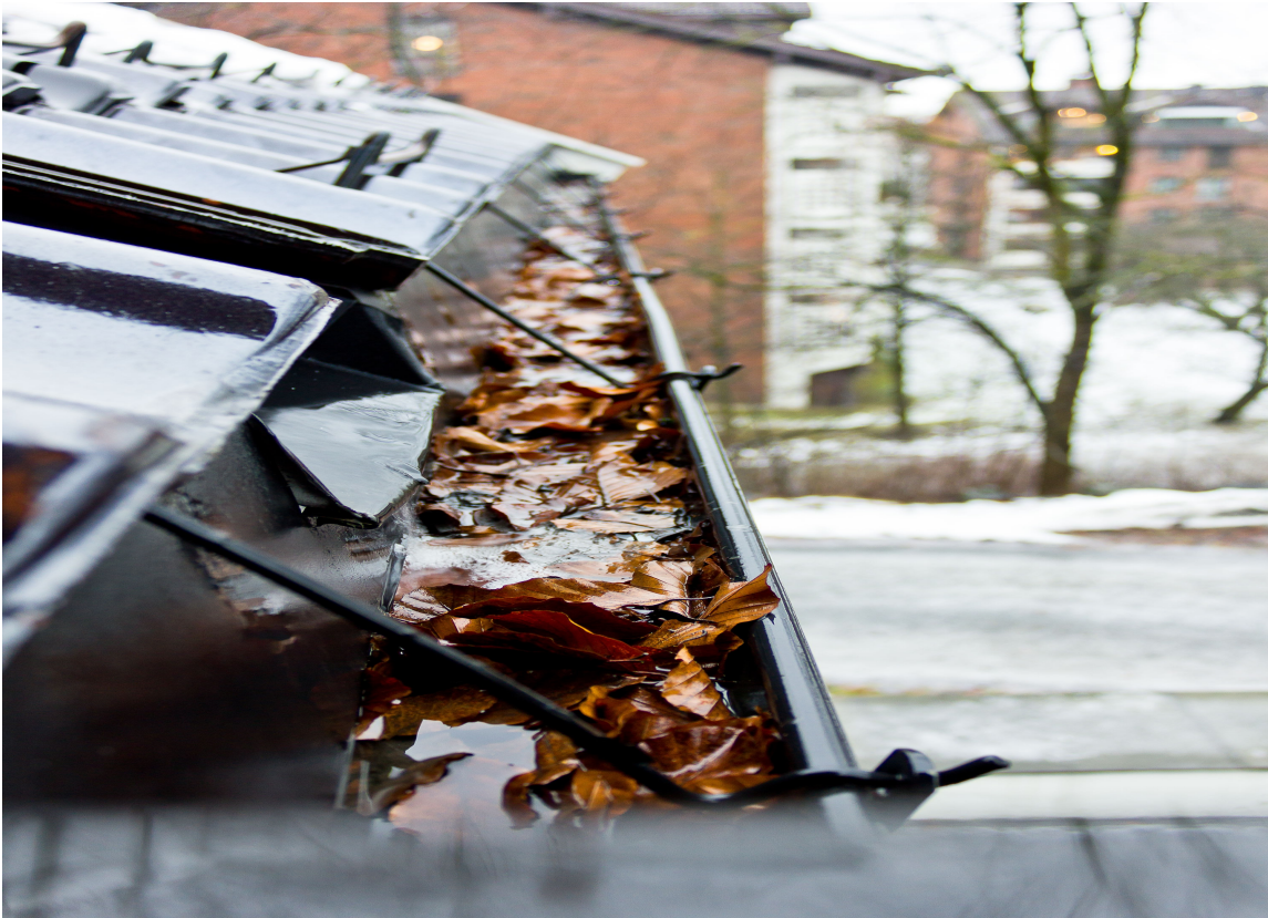
En opprensning av takrenner må gjøres med jevne mellomrom.
