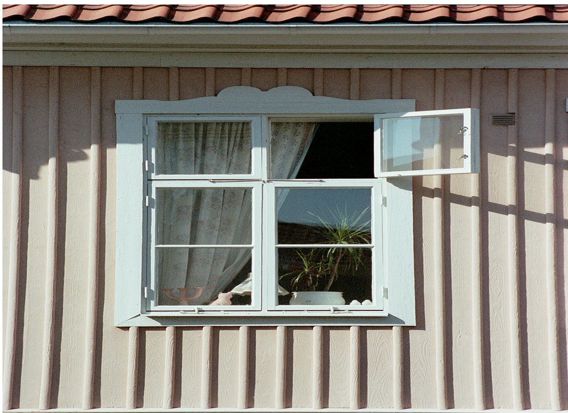
FARGENE FORSTØRRES: Selv en ganske kulørsvak farge oppleves rosa når den kommer på husveggen.
