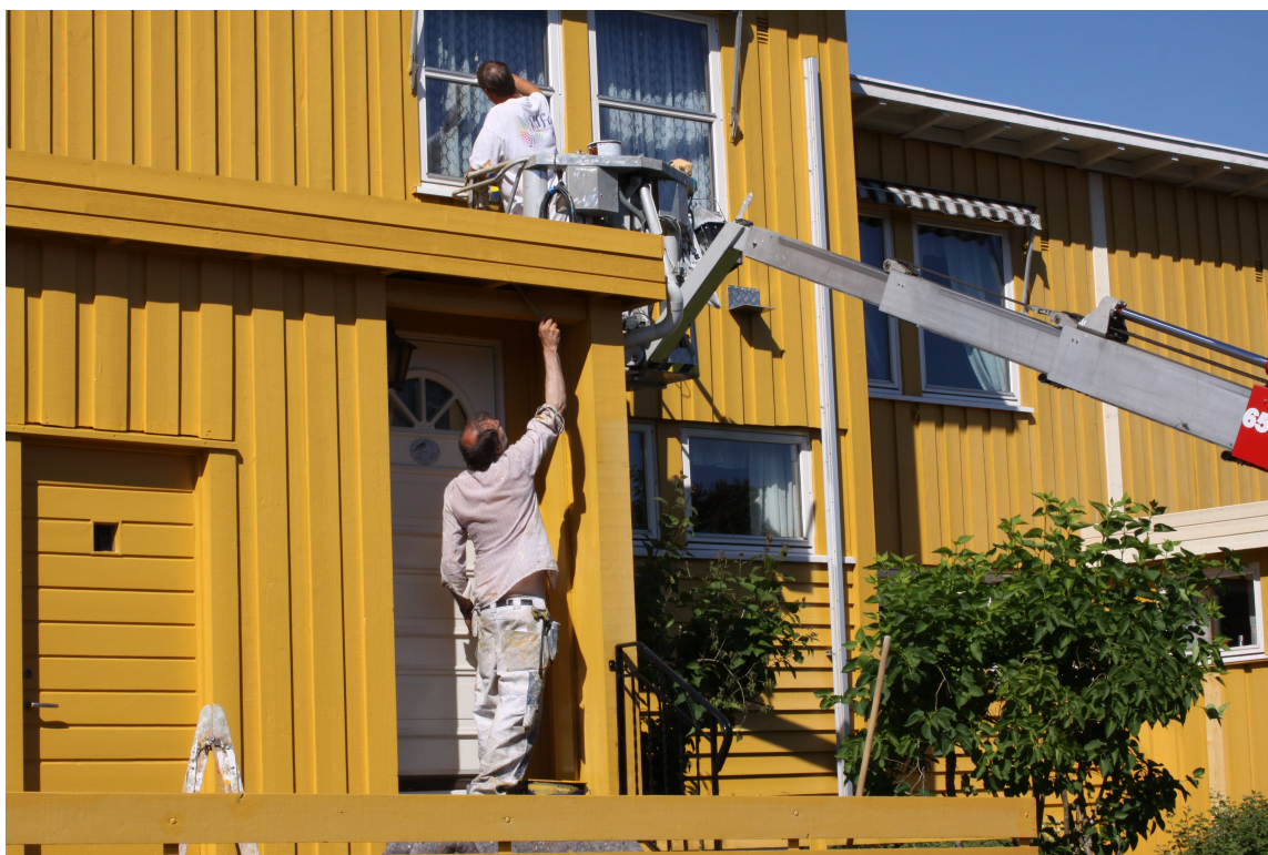
Det blir mer og mer vanlig at også private leier en lift for å male de øverste delene av huset.
