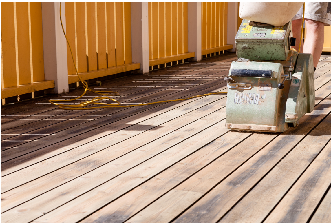
Terrasebordene bør nullstilles med sliping og rens annenhver gang de skal behandles.
