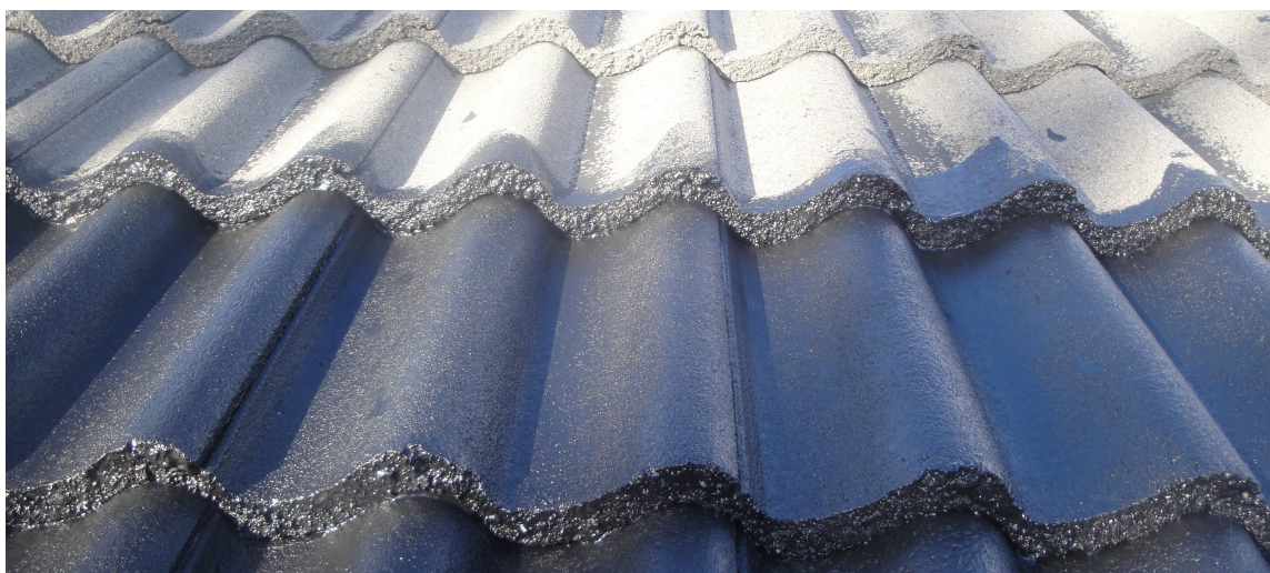
Forskjellen er stor når du får på ny taksteinsolje.
