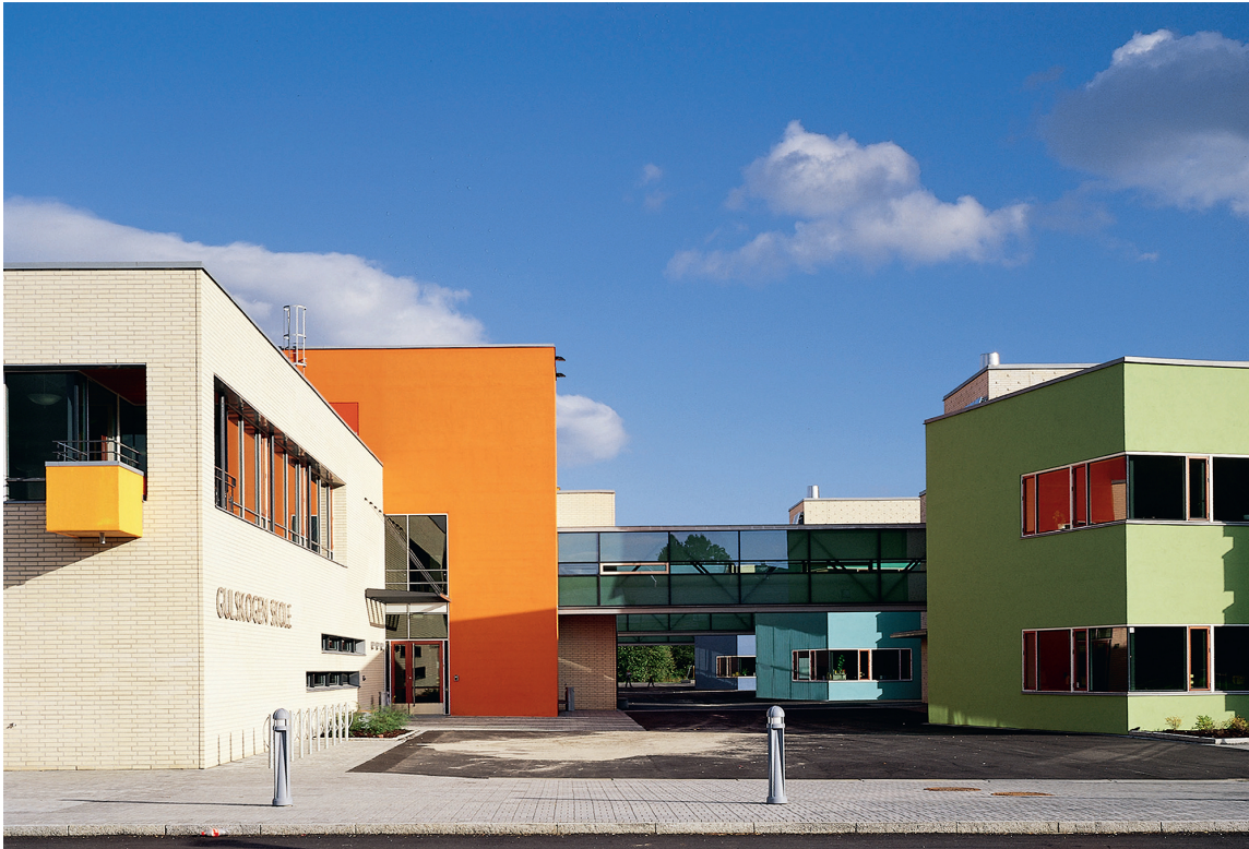
Med riktig behandling holder murhus seg pent lenge. Her fargerike Gullskogen skole i Drammen tegnet av Kristin Jarmund Arkitekter AS. Gullskogen skole er malt med Keim soldalit silikatmaling.
