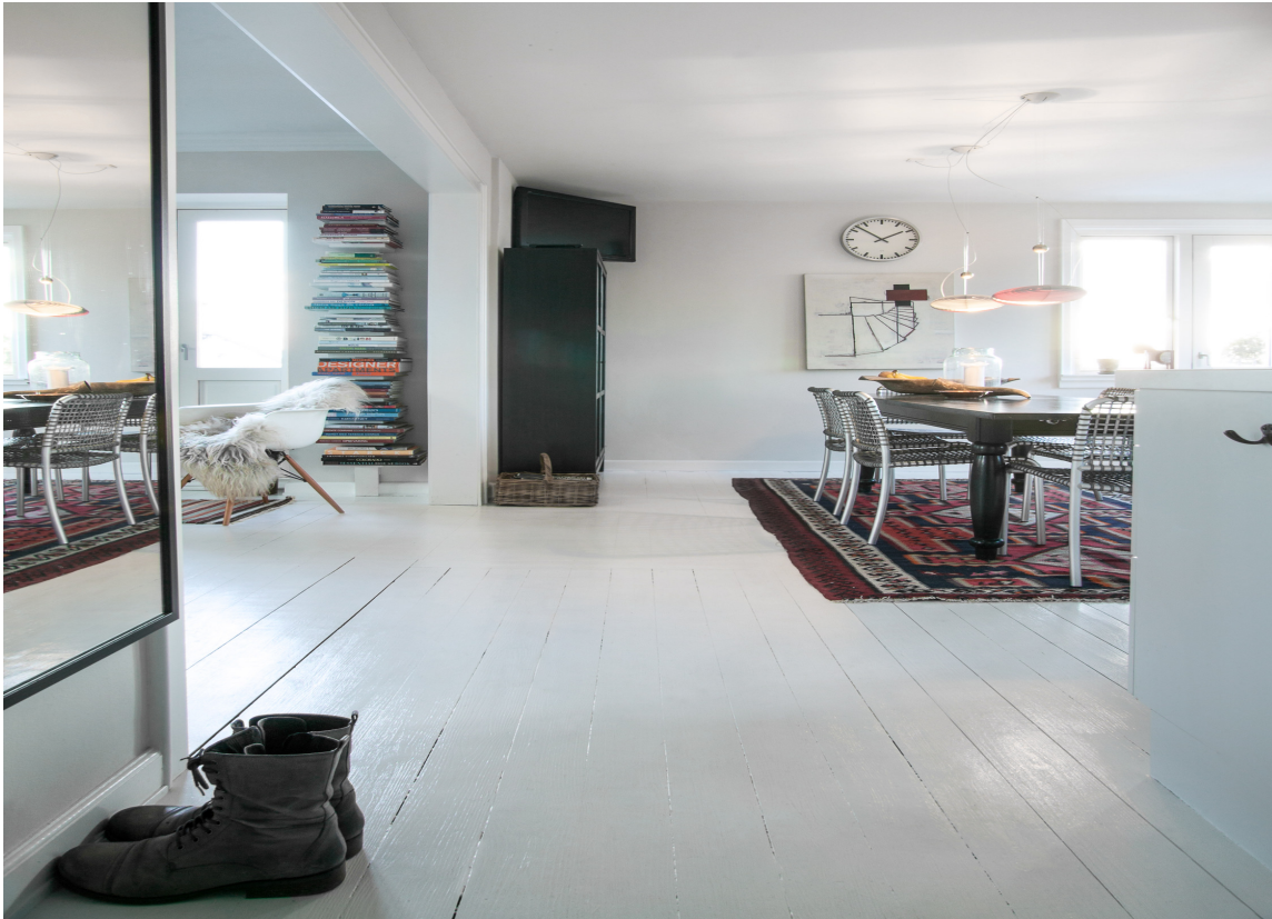
Gulvet er slipt og påført Flügger Interior Stop Primer, samt to strøk Flügger High Finish Interior, glans 90.
