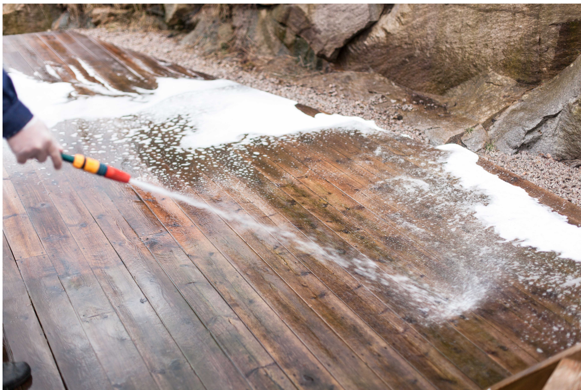
Spyling av gulvet med vanlig hageslange er tryggest.
