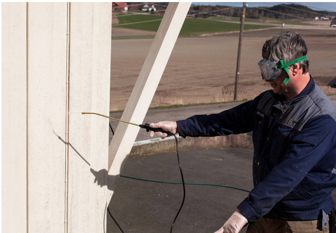
Vaskemiddelet tynnet med vann dusjes på med en lavttrykksprøyte.
