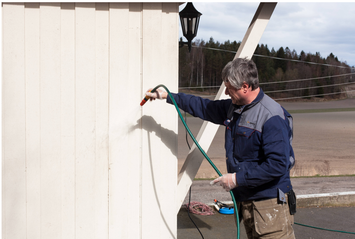
Rengjøringsmiddelet og skitten spyles av veggen - ovenfra og ned.
