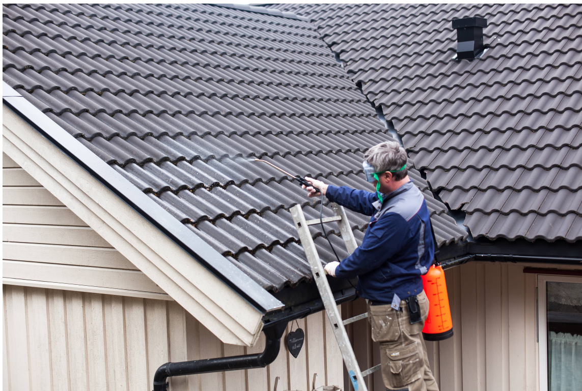
Sopp- og algedreper og deretter husvask - påføres med en spraykanne.
