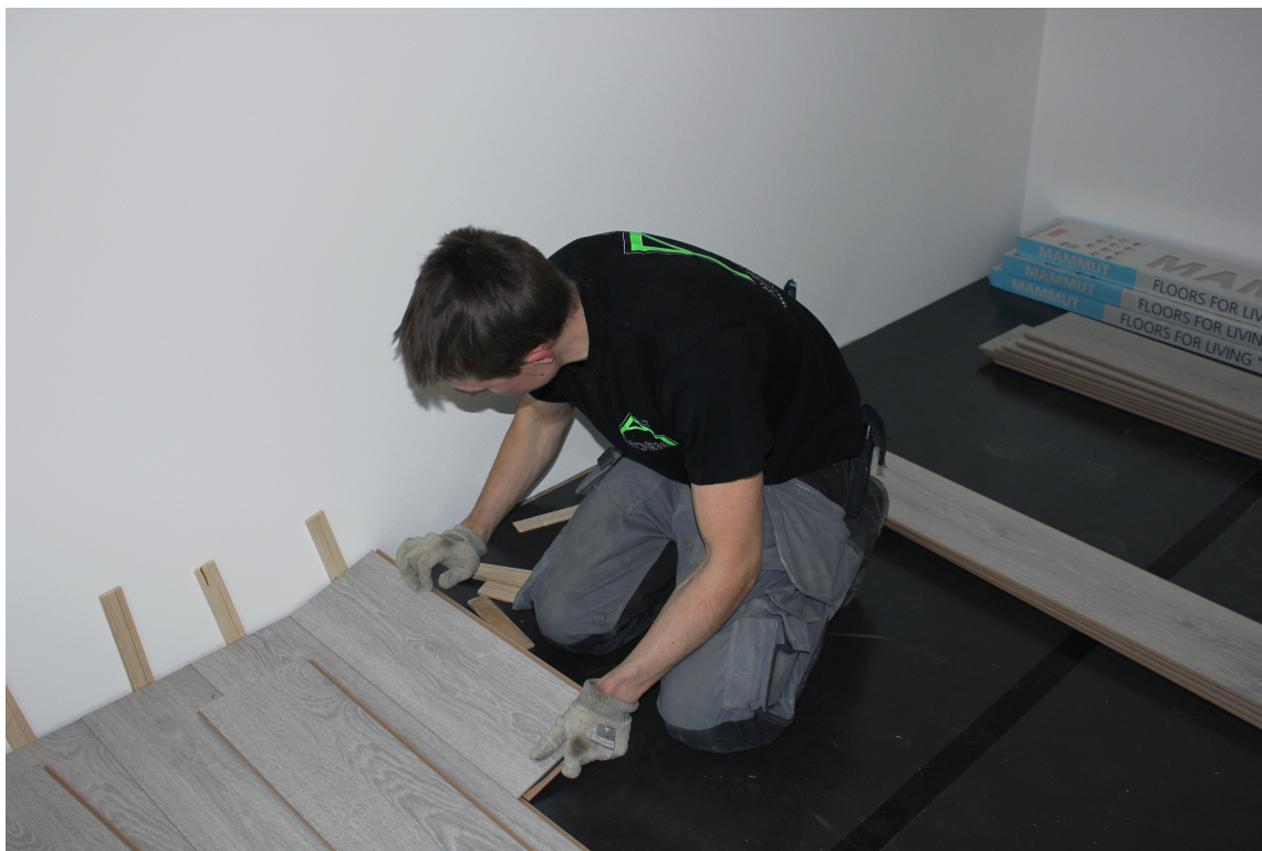
Gulvet legges med cirka 10 millimeters avstand til alle vegger.
