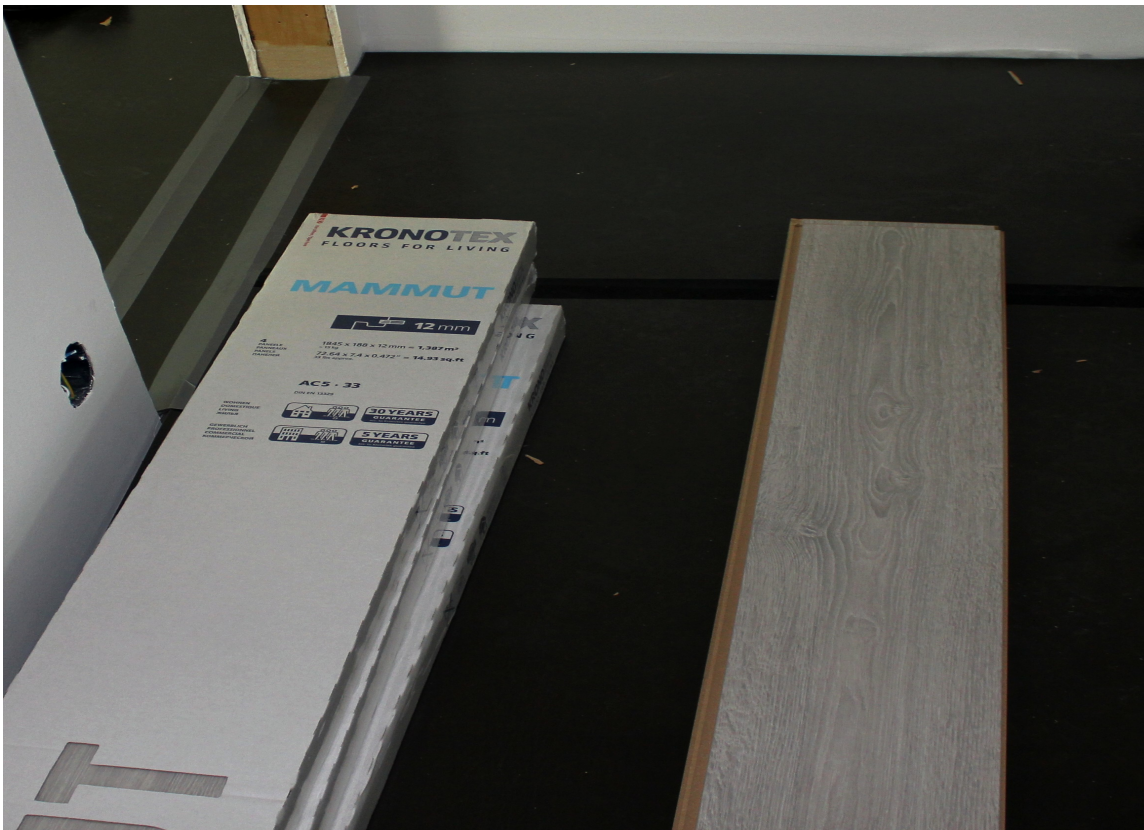
Pakkene åpnes etterhvert som gulvet legges.
