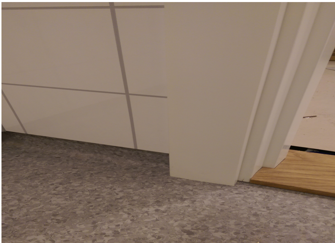
Listverk i HD polystyren kan monteres helt ned mot baderomsgulvet.
