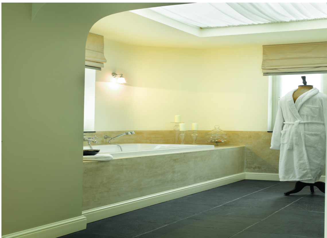
Lister i kunstmateriale tåler helt fint å ramme inn et badekar - hvor en del vannsøl må påregnes.
