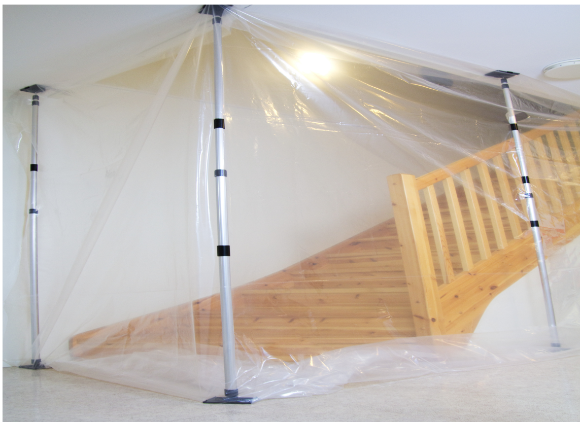
Her kryper ikke noe støv opp i 2. etasje.
