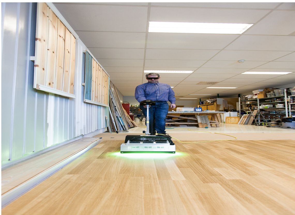
Gulvlakken tørker og herder på et øyeblikk når den utsettes for bestrålingen fra UV-lampen.
