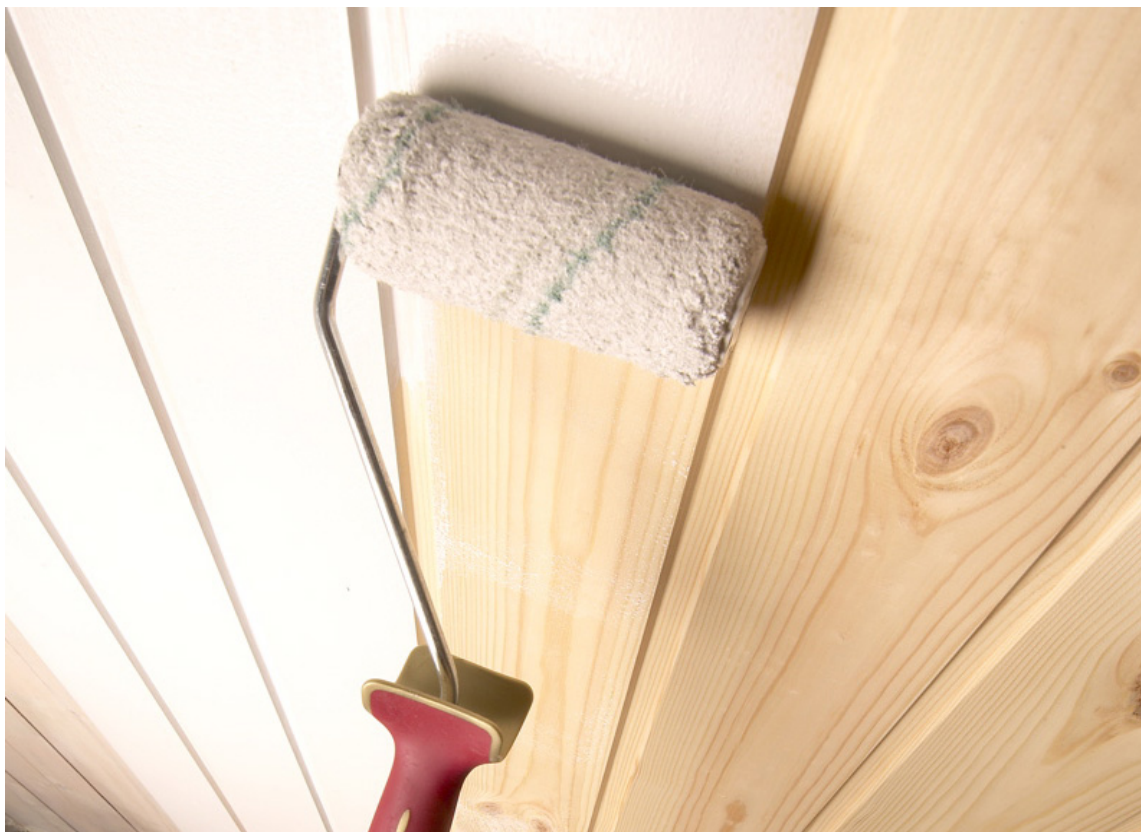
MISFARGING: Grunning gir god vedheft til toppstrøket. Sperrgrunn og isolergrunn forhindrer misfarging.
