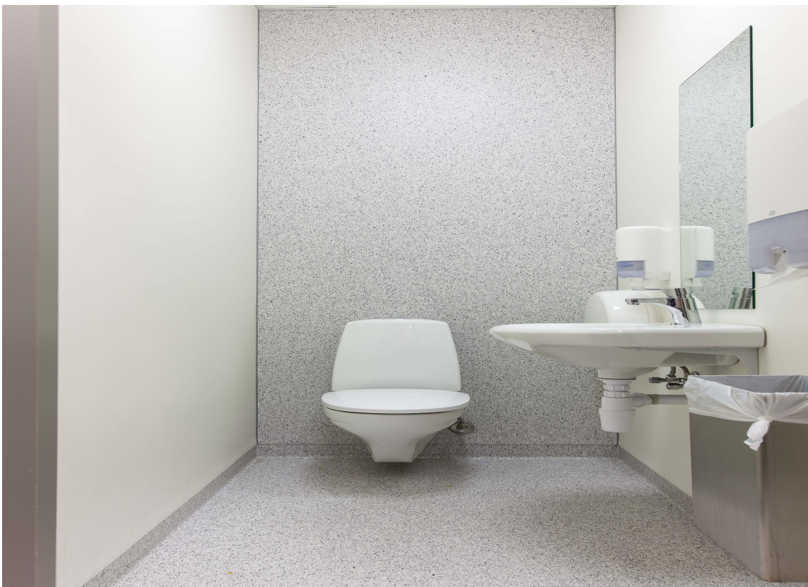
På toalettene er gulvbelegget strukket videre opp på bakveggen, slik at den fremstår nærmest som en fondvegg.
