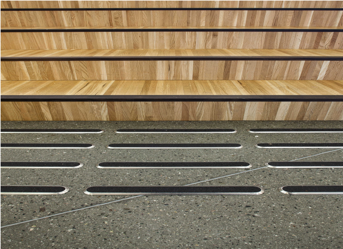
Trappetrinnene i auditoriet er kledd med små lameller i tre, gjerne kalt industriparkett.
