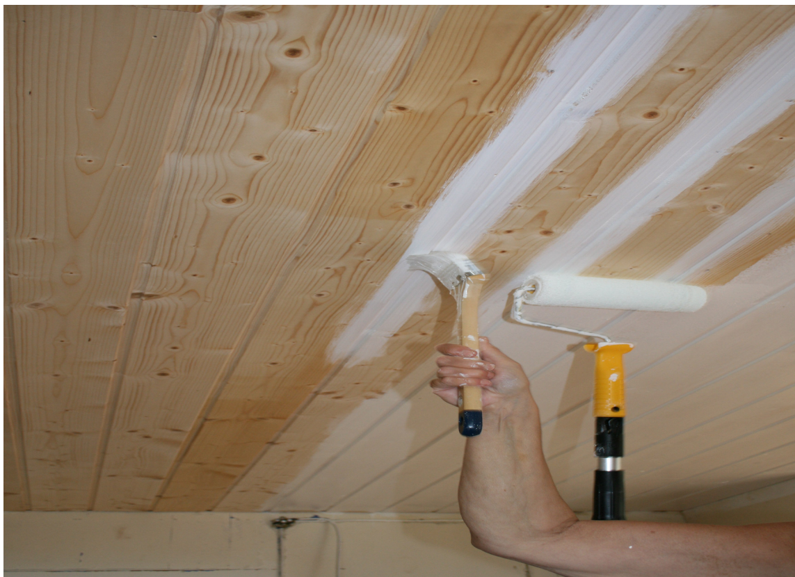
Bruk rull og fordriver for å påføre maling og grunning.
