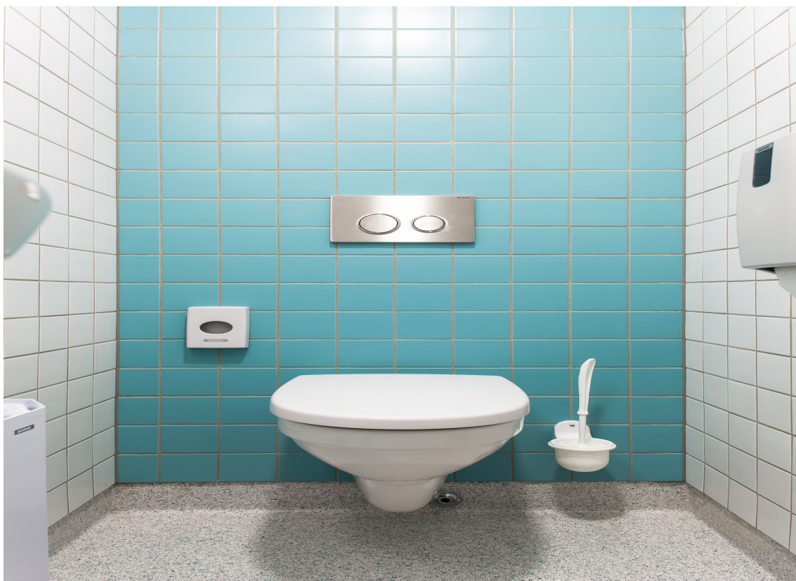
Vegghengt toalett med betjeningsplate i stål tål mye slitasje.
