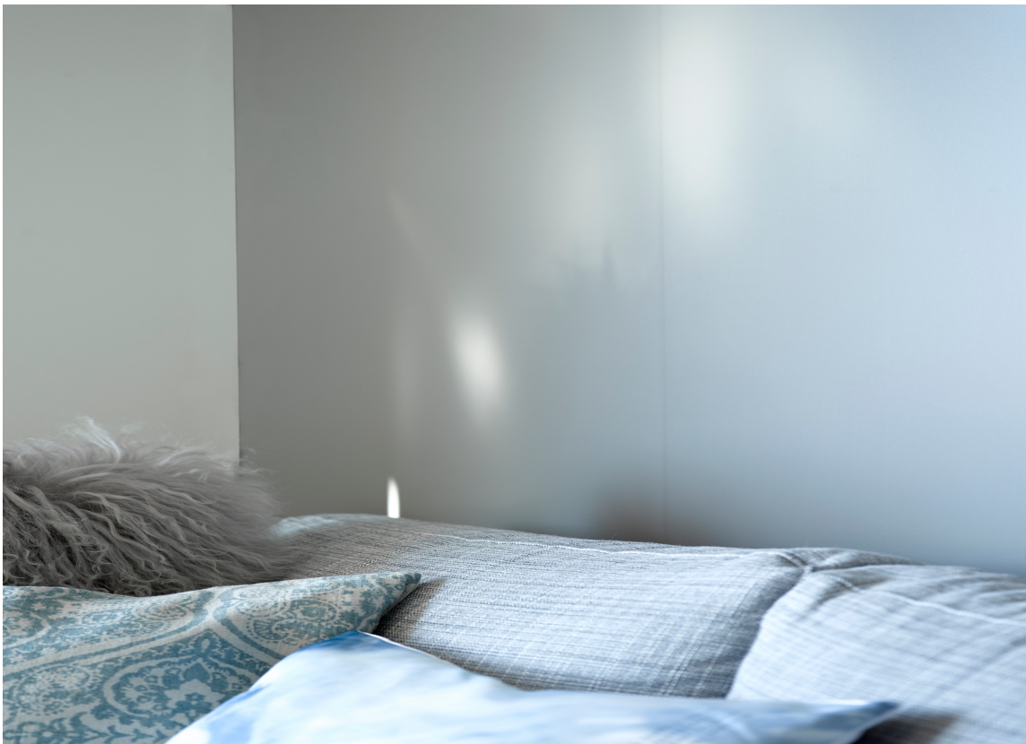
Platene ble montert utenpå opprinnelig vegg.
