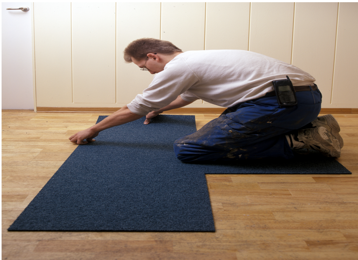
Normalt legges teppefliser løst.
