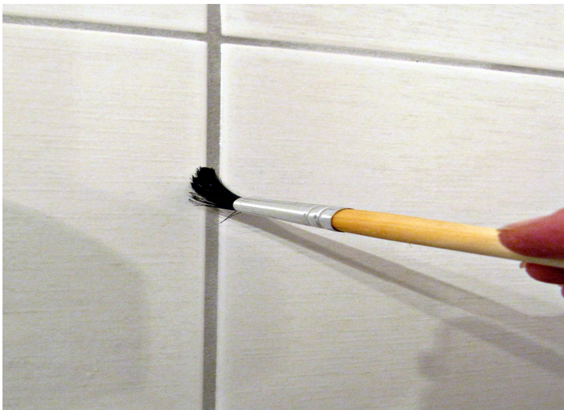
IMPREGNERING: Ved å impregnere fugene, stoppes vannet fra å trekke inn.
