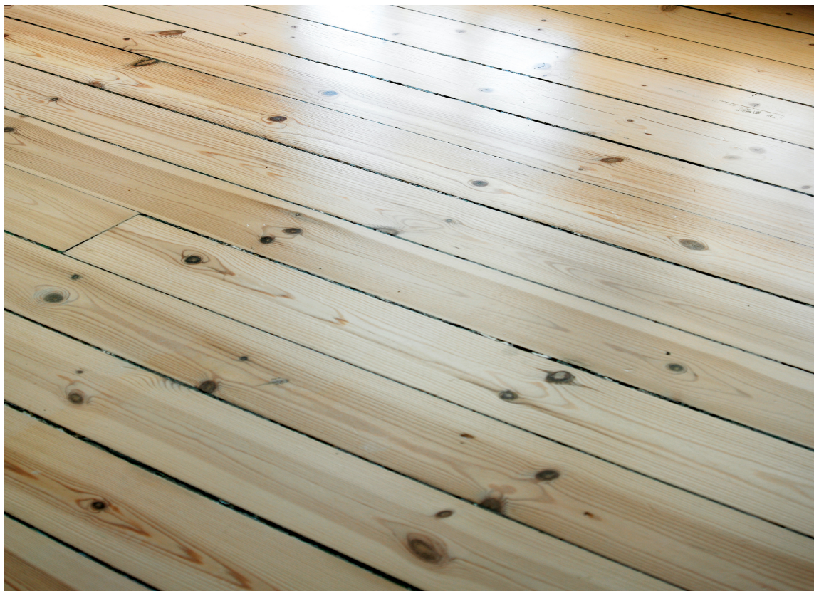
Furugulv påført 1 strøk vanntynnet, hvitpigmentert panellakk og 2 strøk vanntynnbar parketlakk fra Nordsjö.
