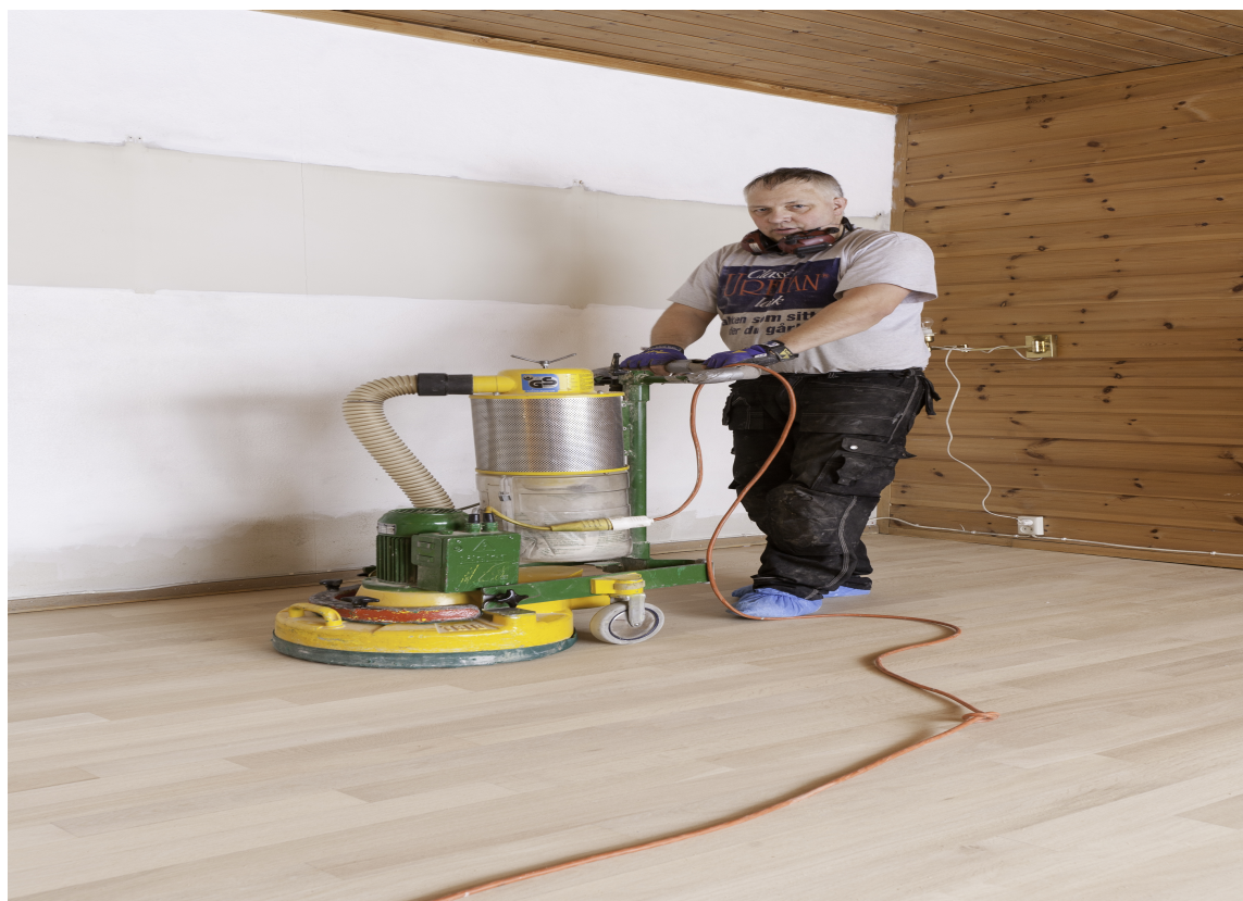
9. Polermaskinen fra Lägler finnes det få av i Norge. Den har tre roterende pads der man kan feste slipepapir eller slipenett laget av silisium, som gir et flott resultat.
