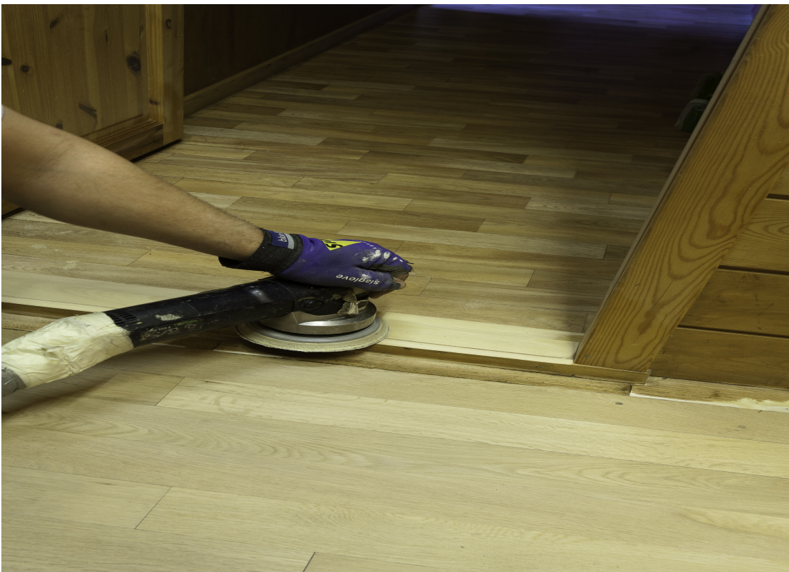
8. Når gulvet er ferdig slipt, før det lakkeres, skal det poleres. Den store polermaskinen har også en egen støvoppsamler. Bruk skobeskyttere på beina for å ikke lage merker fra sålene på gulvet.
