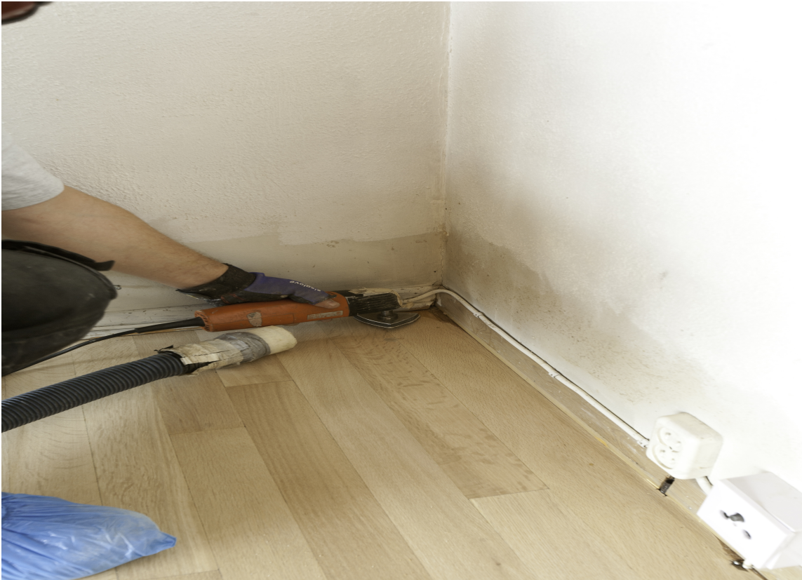
7. Terskler slipes med en rotasjonssliper og trekantsliperen.
