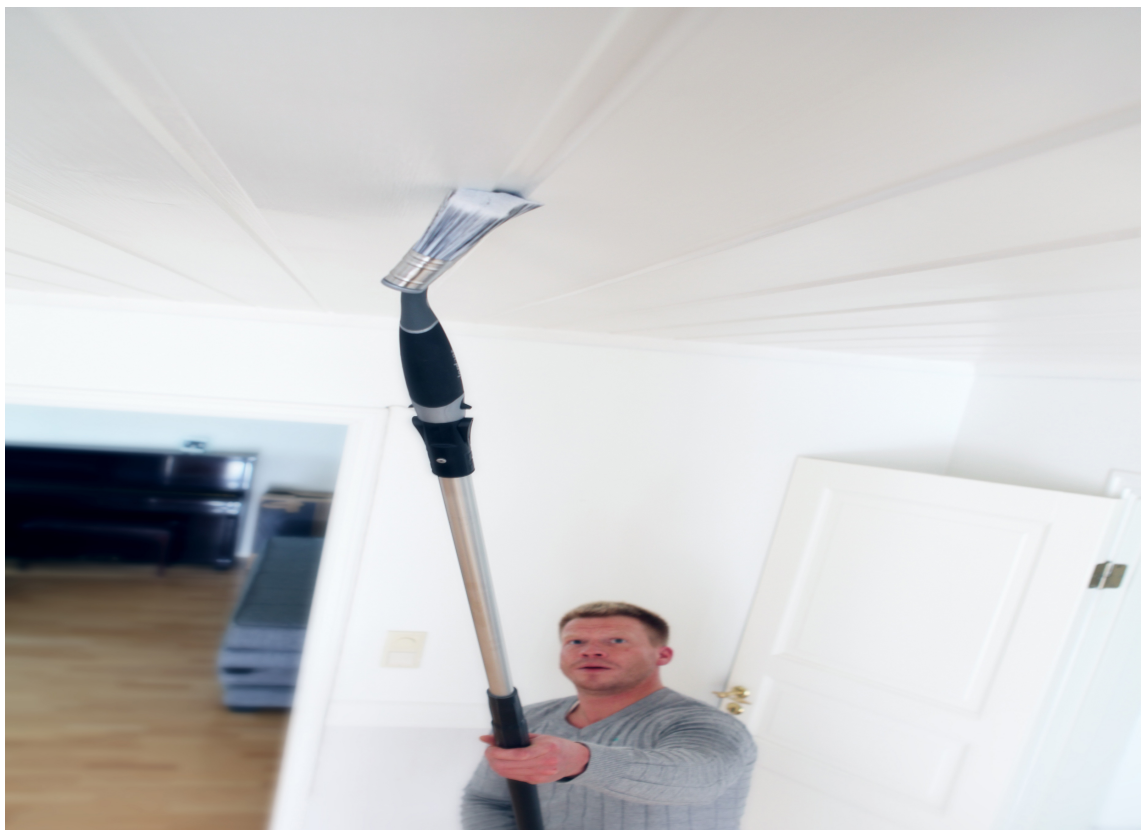
LANGSKAFT: Sett penselen på et forlengerskaft. Det gir økt rekkevidde og går kjappere enn å bruke stige.
